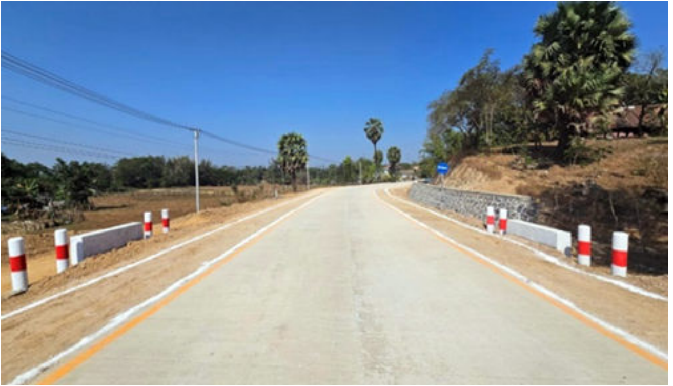
သိမ်တော်ကြီး-ကမော့ကစင်လမ်း ကွန်ကရစ်လမ်းအား တွေ့ရစဉ်။
