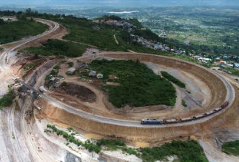
ရွှေညောင်-တောင်ကြီး ရထားလမ်း အဆင့်မြှင့်တင်ခြင်း ဆောင်ရွက်ပြီးစီးမှုအား တွေ့ရစဉ်။
