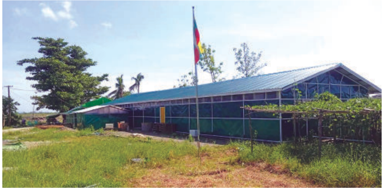
စိုက်ပျိုးရေး၊ မွေးမြူရေးနှင့် ဆည်မြောင်းဝန်ကြီးဌာနက ဆိုင်ကလုန်းမှန်တိုင်း “မိုခါ” သဘာဝဘေးကျရောက်ပြီးနောက် မြန်မာနိုင်ငံ ငါးလုပ်ငန်းအဖွဲ့ချုပ်က လှူဒါန်းငွေ ကျပ်သိန်း ၃၀၀ ဖြင့် သားဖောက်ရုံအဆောက်အအုံတစ်ခုအား ပြန်လည်ထူထောင်တည်ဆောက်ထားစဉ်။
