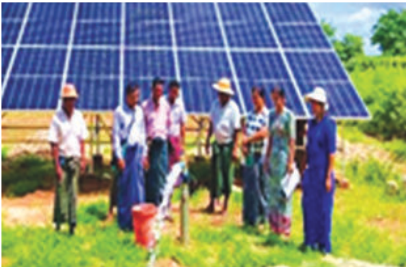
မကွေးမြို့နယ်၊ အလယ်ဘိုကျေးရွာ ကျေးလက်ရေရရှိရေး တွင်းနက်တူးဖော်လုပ်ငန်းများ ဆောင်ရွက်နေစဉ်။
